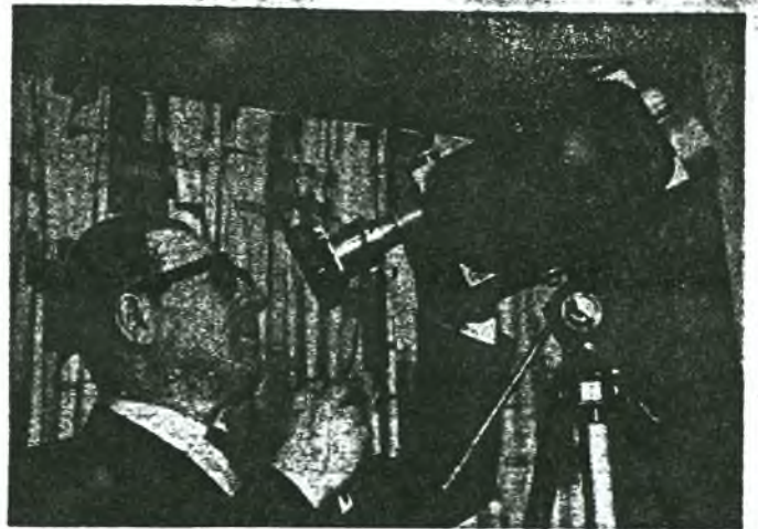
M. Adélard Rousseau a fabriqué ce télescope réfracteur, portatif et facilement maniable, qui permet des grossissements de près de 200 fois.
